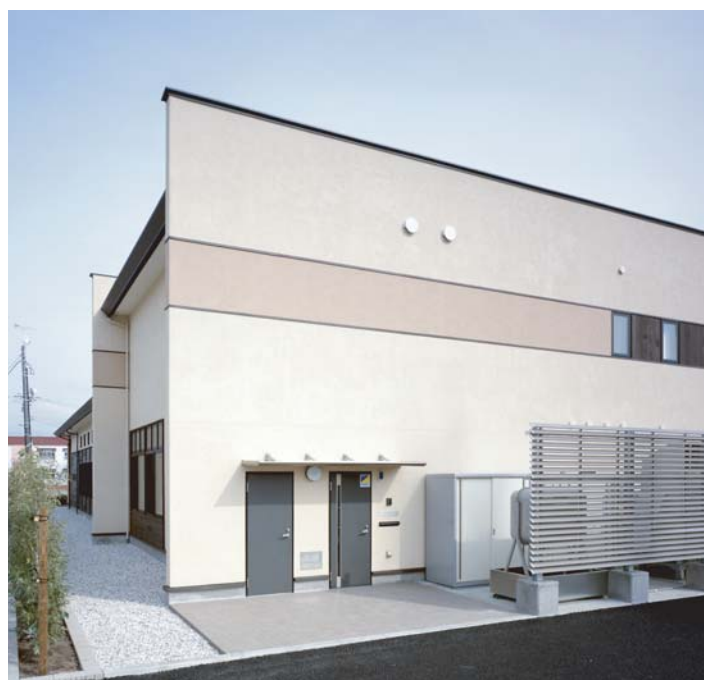
北側の雪だまりスペースと設備機器をルーバーで覆った西側ファサード
